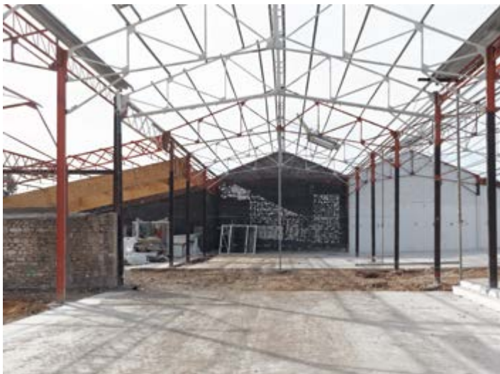
Entrepôt-galerie du Confort Moderne en travaux, 2016 Photo : Éric Tabuchi
